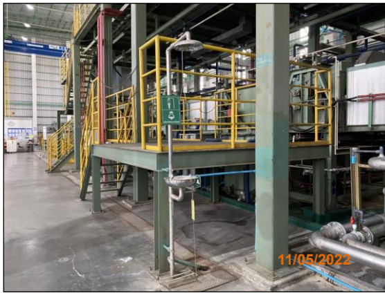
ภาพที่ 2.2-17 ฝักบัวล้างตัว และอ่างล้างตาฉุกเฉิน
