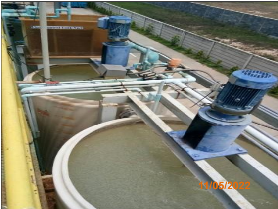
ระบบบำบัดน้ำเสียปนเปื้อนโครเมียม
