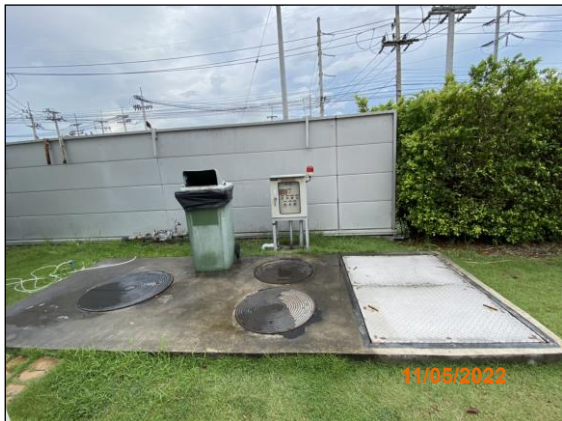
ภาพที่ 2.2-5 ระบบบำบัดน้ำเสียสำเร็จรูป
