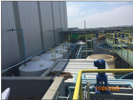
ภาพที่ 2.2-2 ถังรองรับน้ำเสียจากกระบวนการผลิต
