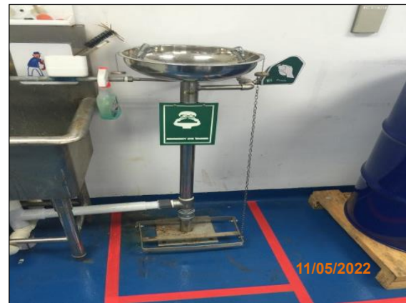
ภาพที่ 2.2-17 ฝักบัวล้างตัว และอ่างล้างตาฉุกเฉิน
